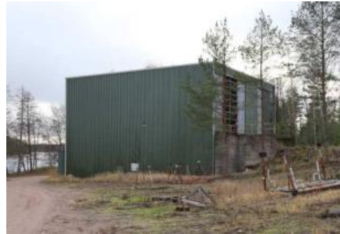
Kuva 23, Lämpökeskus (Stadion ARK)
