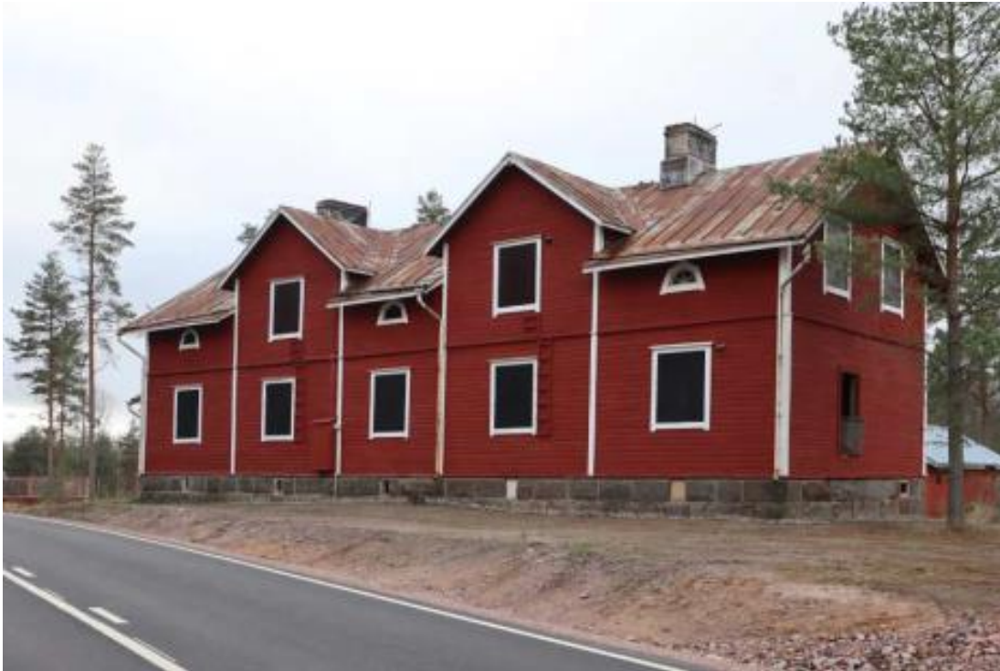
Kuva 15, Banvillan (Stadion ARK)
